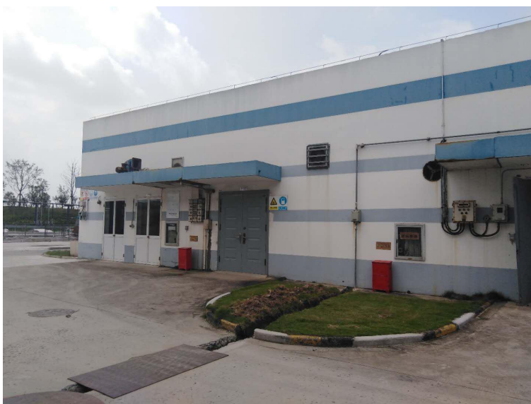
图 4-1 甲类仓库外部情况
