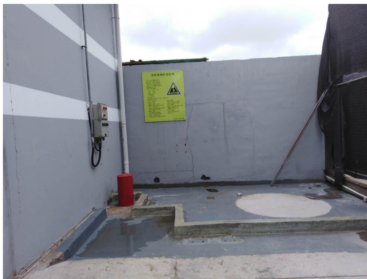
图 4-9 危废仓库外部情况
