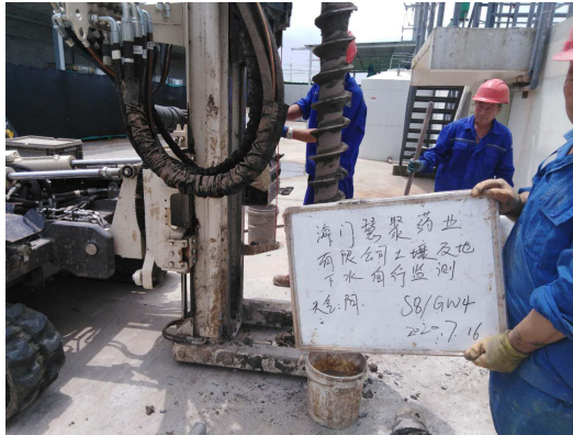
附图 6 监测井钻孔
